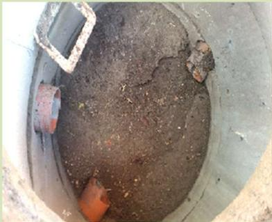
Wir saugen den Inhalt der Sickerschächte ab und entfernen mittels gleichzeitigen Hochdruck-einsatzes die oft Meter hohen Schlammschichten. Wenn der Mutterboden wieder sichtbar ist, dann ist der Sickerschacht wieder bereit für die nächsten Regenwassermengen.
